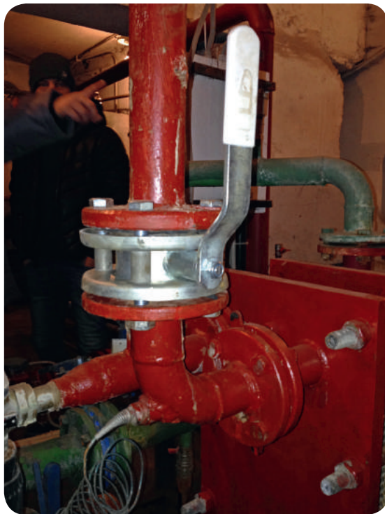
КОНТУР ГВС ПОСЛЕ ПЛАСТИНЧАТОГО ТЕПЛООБМЕННИКА
